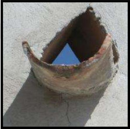
Las del tipo "B" están realizadas en barro recocido a manera de cuerpo cilíndrico con borde abocinado, su longitud en promedio es de 45 cm y su diámetro interior es de 10 cm
