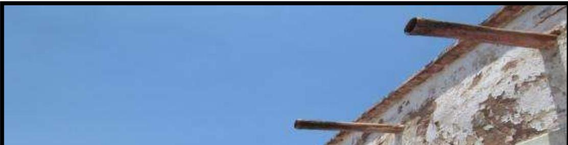
Por último las del tipo “C” están formadas por la sección transversal de un prisma rectangular, están en metal y su conservación es casi nula derivado de que no se trató el material con ningún recubrimiento al momento de su colocación o posterior a ésta, su base es en promedio de 10 cm, una altura de 5 cm y un largo de 45 cm.
